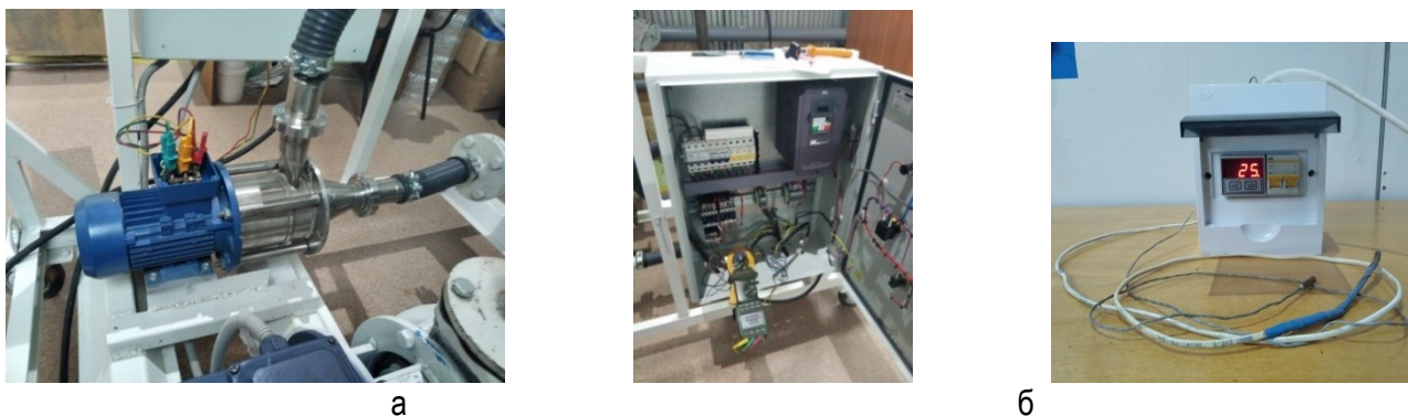
Рис. 2. Определение рабочих параметров при проведении эксперимента: а – замер потребляемой мощности; б – терморегулятор с датчиком температуры
