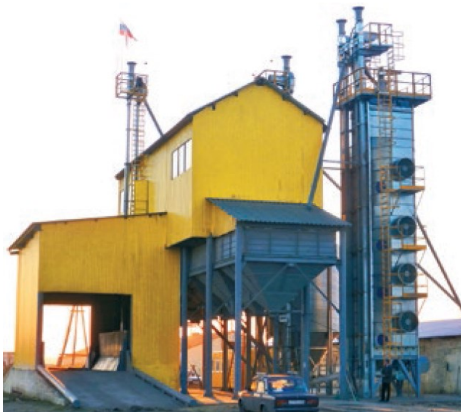
Рис. 2. Общий вид зерноочистительно-сушильного комплекса в ООО «Агролад» Первомайского района Алтайского края
