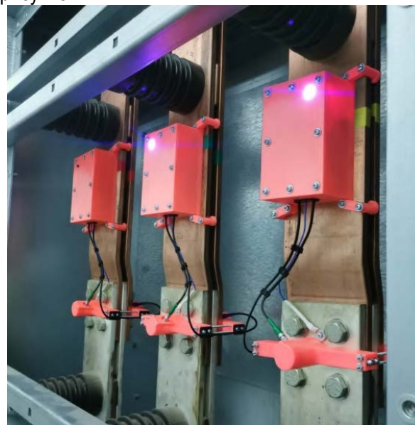
Рис. 4. Прототип автономного УУЭ для измерения параметров ПКЭСШ
